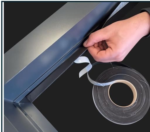
Auf die Auflagefläche der jeweils 3 Winkelprofile wird das selbstklebende EPDM-Band aufgeklebt.
